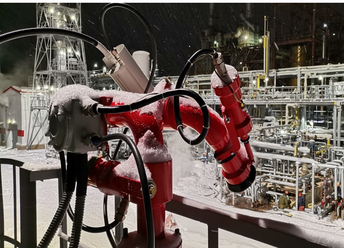
ООО «ЛУКОЙЛ-Ухтанефтепереработка» г. Ухта, Техническое перевооружение ЛС с дистанционным управлением на технологической установке ГДС-850.
